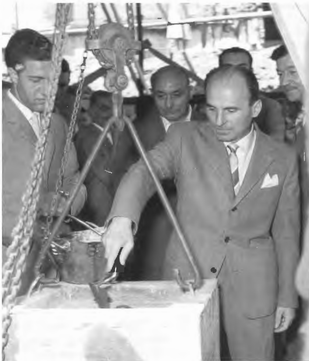
Tenconi pone la prima pietra per la costruzione del II lotto INA (6 luglio 1952).
