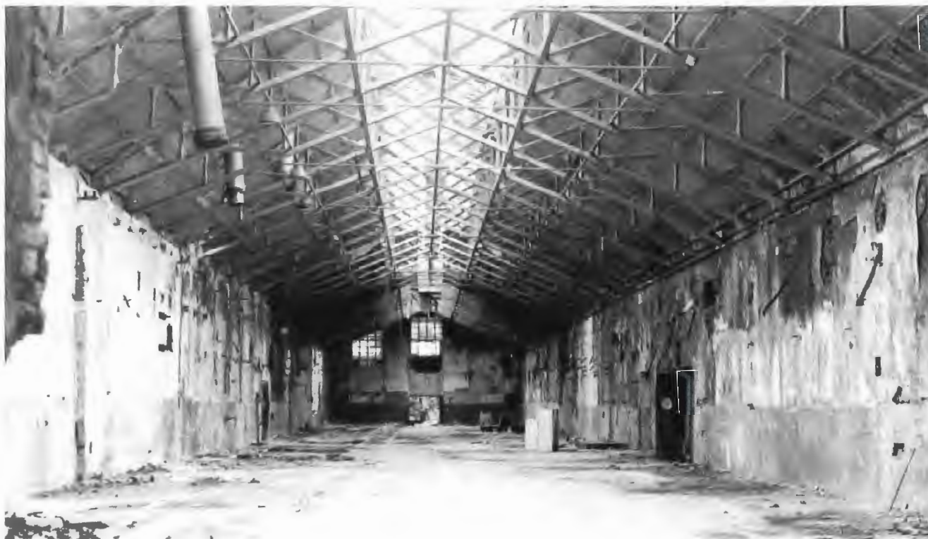
L'interno di un capannone della Cantoni, come appare oggi.
