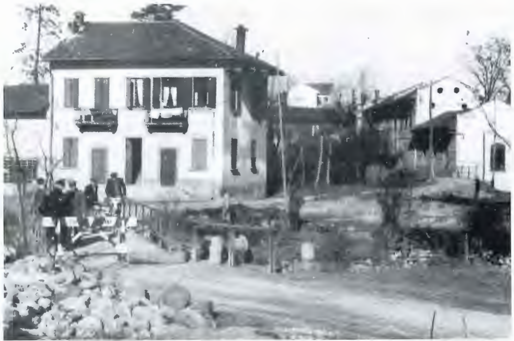
Il vecchio ponte della Gabinella prima della demolizione.
