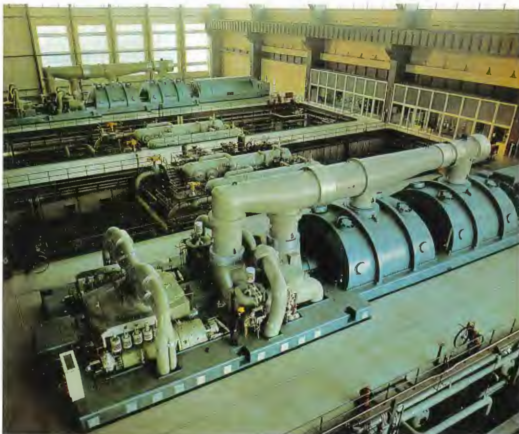
Franco Tosi: due turbo-alternatori Tosi Westinghouse (Centrale di Turbigo).
